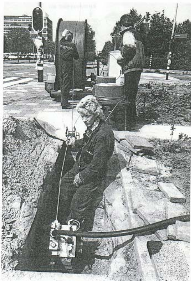
Fig. 2. Het prototype van de Cablejet, nog in z'n eentje aan het werk in combinatie met de "Van den Akker"-haspel.
